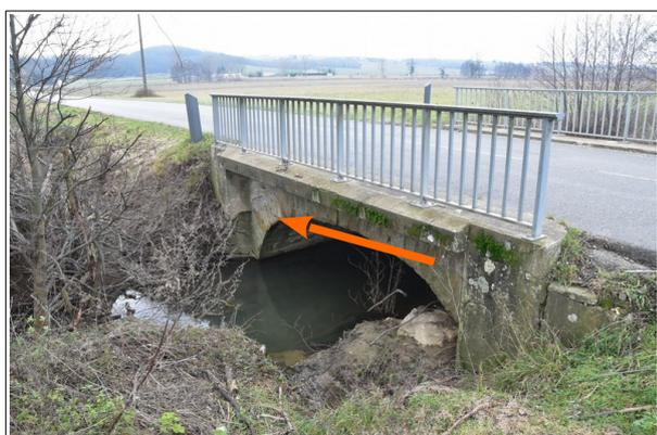
Photo 5: pont de la RD36b avec présence d'obstacles pouvant favoriser la formation d'embâcles. Une laisse de crue est peinte sur la voûte de l'ouvrage (flèche sur la photo).
