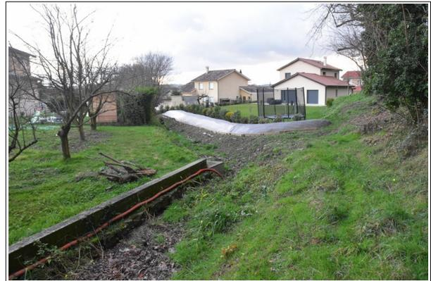
Photo 20: petite levée de terre de quelques décimètres de hauteur protégeant une propriété.
