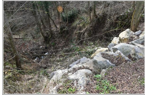
Photo 39: glissement de terrain localisé en bordure de la route des Combes (secteur des Cures) et confortement du talus aval à l'aide d'énrochements.
