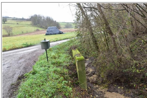
Photo 6: vue du lit du ruisseau des Bugnes au franchissement de la route de Saint-Germain (lit et pont obstrués par des dépôts).
